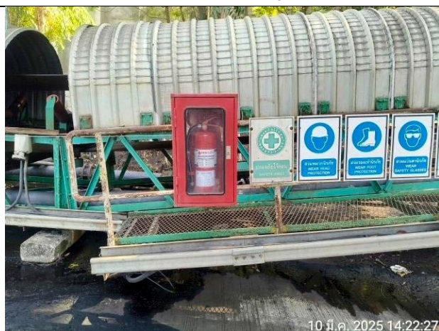
ถังดับเพลิงชนิดผงเคมีแห้ง ด้านข้างของสายพานลำเลียงถ่านหิน BC1
