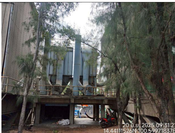
รูปที่ 2.2-24 เครื่องดักฝุ่น (Bag Filter) บริเวณโกรกลองสินค้า
