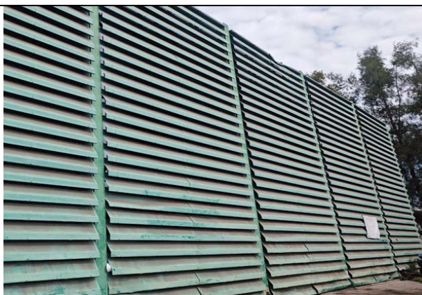
รูปที่ 2.2-17 กำแพงกันลมบริเวณหน้าท่าเทียบเรือ
