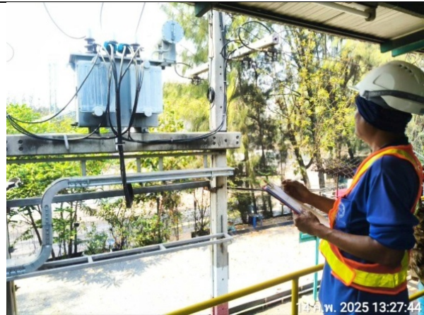
การตรวจสอบหม้อแปลงไฟฟ้า
