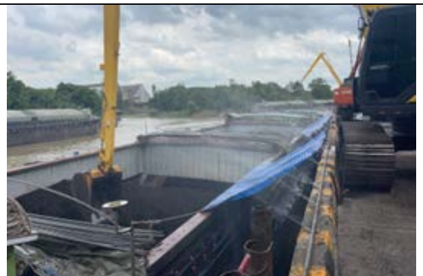
ระบบสเปรย์น้ำบนขอบท่าเทียบเรือ
