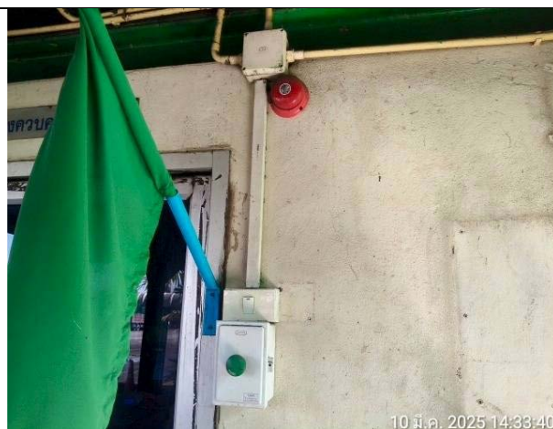
อุปกรณ์ส่งเสียงสัญญาณแจ้งเหตุเพลิงไหม้ สำนักงานบริษัท บ้านปู จำกัด (มหาชน)
